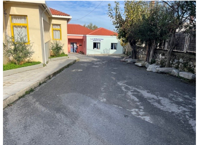
Εικόνα 6: Άποψη 1ου Δημοτικού σχολείου Ανωγείων
